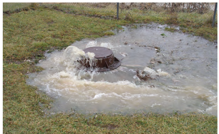
Manhole overflow
