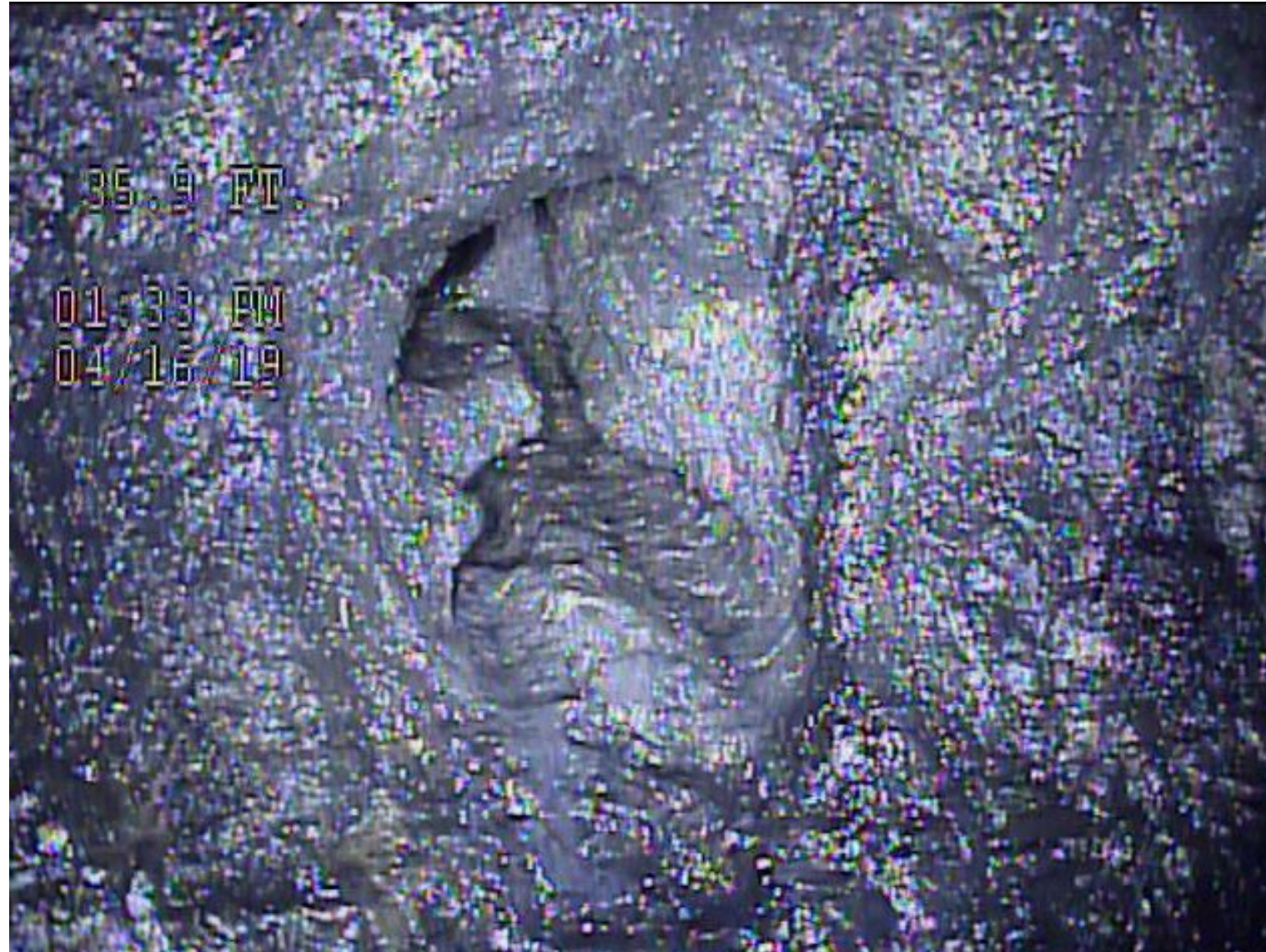
West Drain Conduit Location B Hole in Drain Conduit
